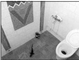
Сечовідвідний, без використання води, туалет, встановлений в житловому будинку у Стокгольмі.
